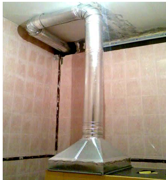
Дизель-генераторная установка с применением вентиляционного короба (удаление из помещения угарного и горячего воздуха).
