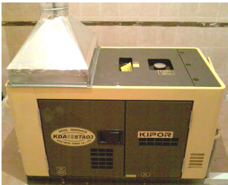
Дизель-генераторная установка с применением вентиляционного короба (удаление из помещения угарного и горячего воздуха).
